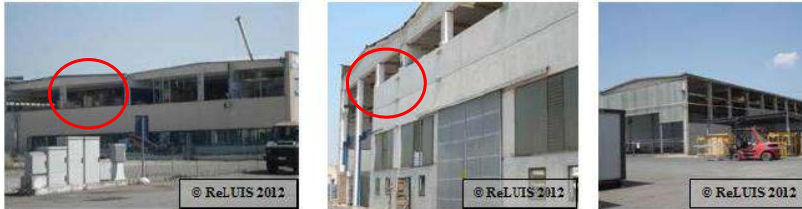
Figura 26 – Collasso pannelli orizzontali di tamponamento in strutture monopiano prefabbricate
