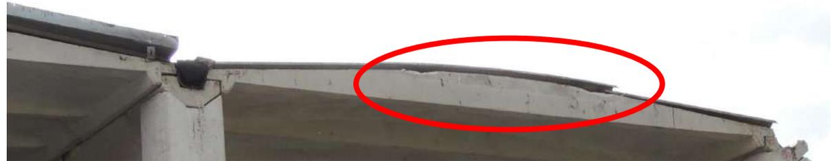
**Si evidenziano rotture delle connessioni a spinotto del solaio di copertura e rotture delle connessioni dei pannelli prefabbricati.**
