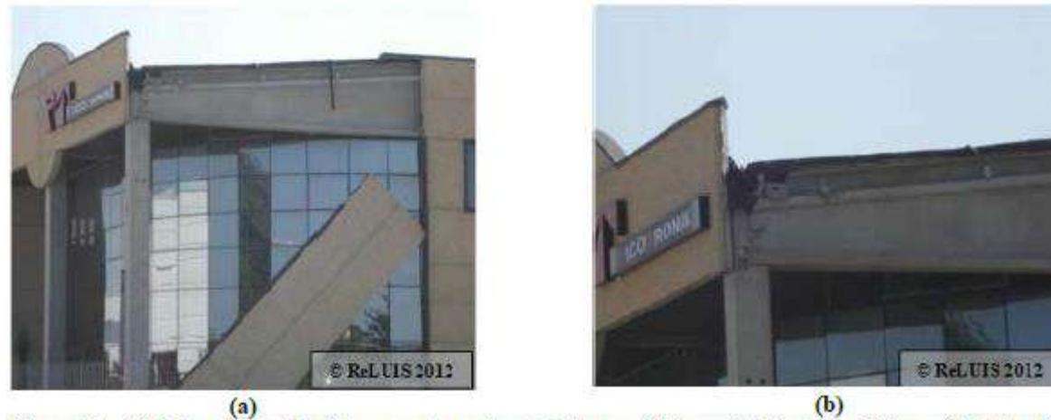
Figura 38 – (a) Collasso pannello di tamponatura orizzontale in un edificio prefabbricato multipiano e (b) dettaglio connessione del pannello in corrispondenza del pilastro
