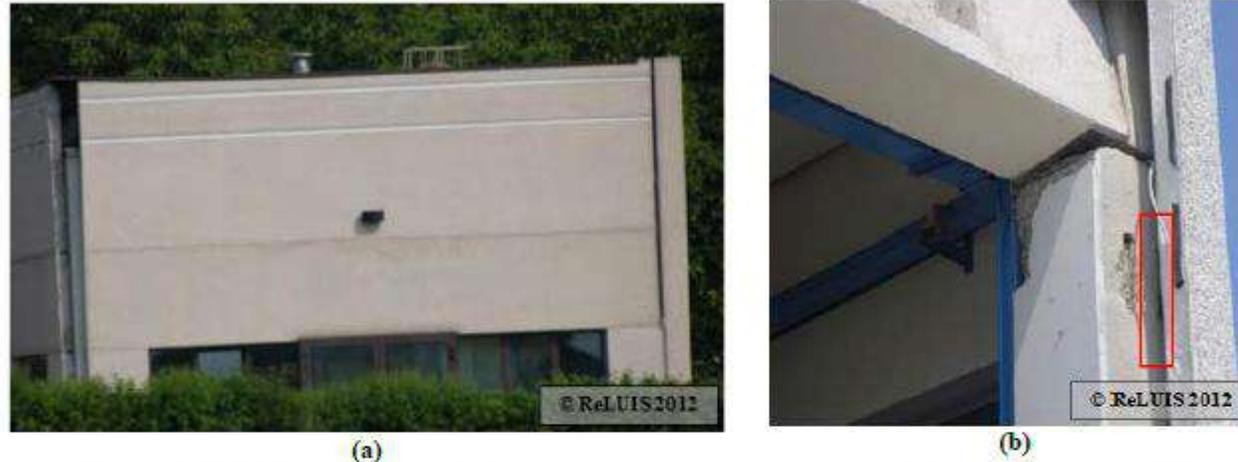
Figura 37 – (a) Collasso avvenuto e (b) collasso imminente pannelli di angolo in edificio monopiano prefabbricato con pannelli orizzontali di tamponamento
